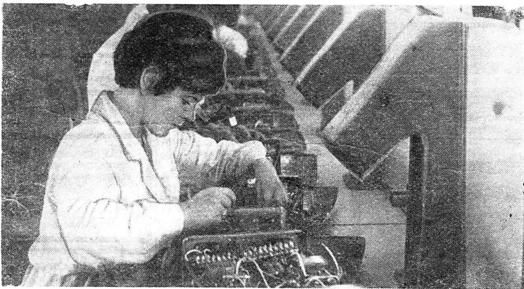
Ленінградське учбово-виробниче підприємство. Складальний цех. На імпульсному конвейері йде складання підсилювачів для пересувних кіноапаратів. На фото: монтажниця Е. І. Петецька.
