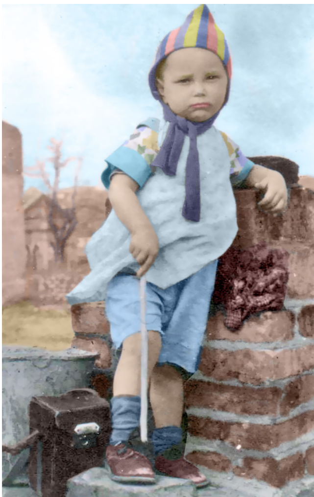
На руїнах зруйнованого будинку біля УВП УТОГ м. Кіровоград
