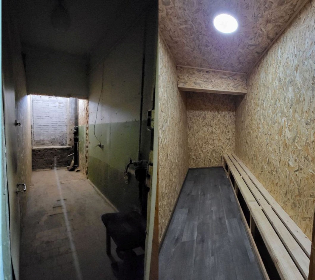
Ремонт роздягальні (оббивка стін ОСБ плитами, заміна проводів)
