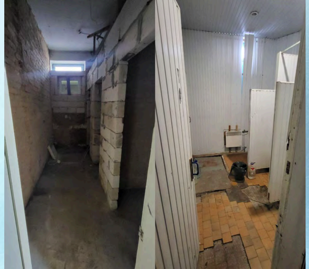
Ремонт туалету (побудовані нові стіни, залита підлога та встановлені унітази)
