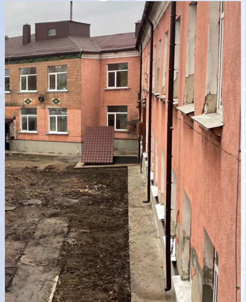
Ремонт відмостки виробничого корпусу Конотопського УВП УТОГ
