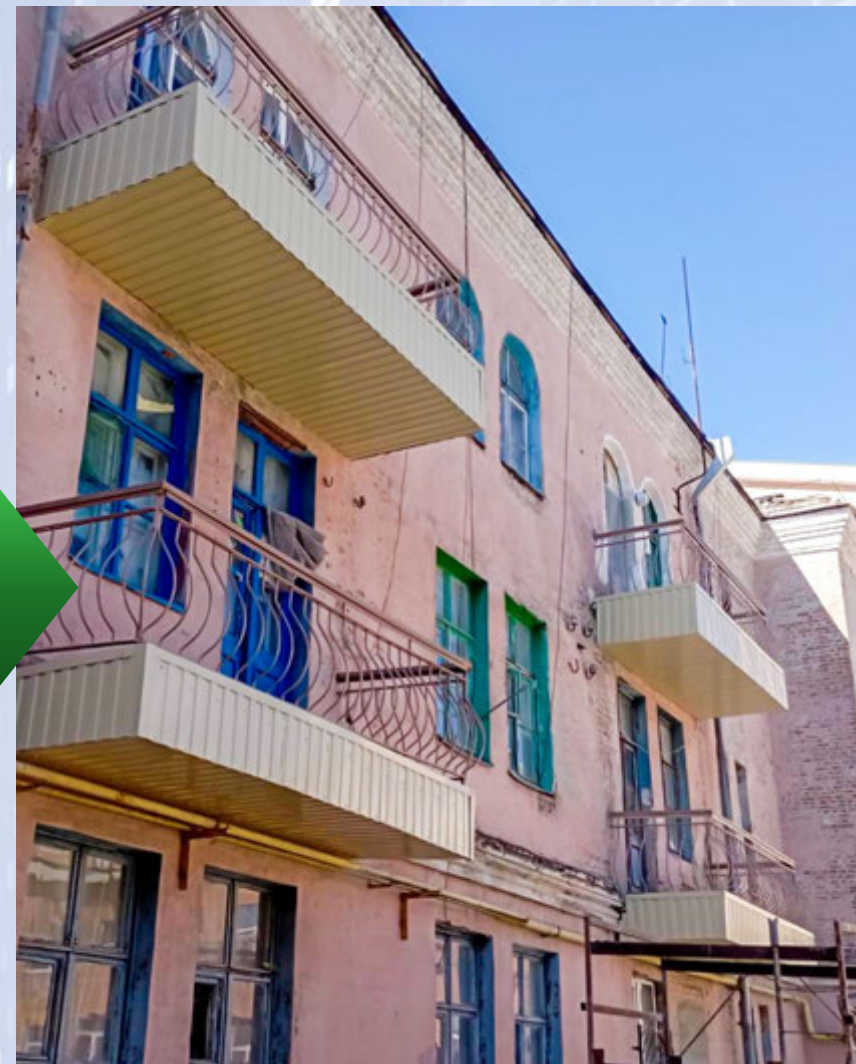
Капітальний ремонт балконів гуртожитку ПОГ «Кропивницьке УВП УТОГ»
