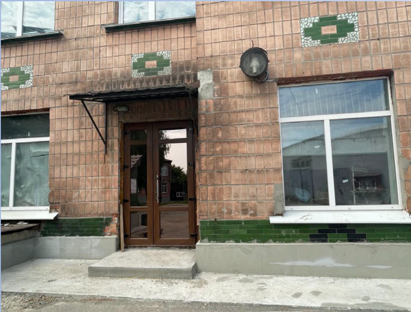
Ремонт відмостки виробничого корпусу Конотопського УВП УТОГ
